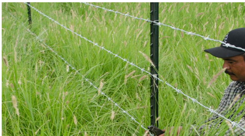
Figura 2.8. Cerca de alambre de púas.
